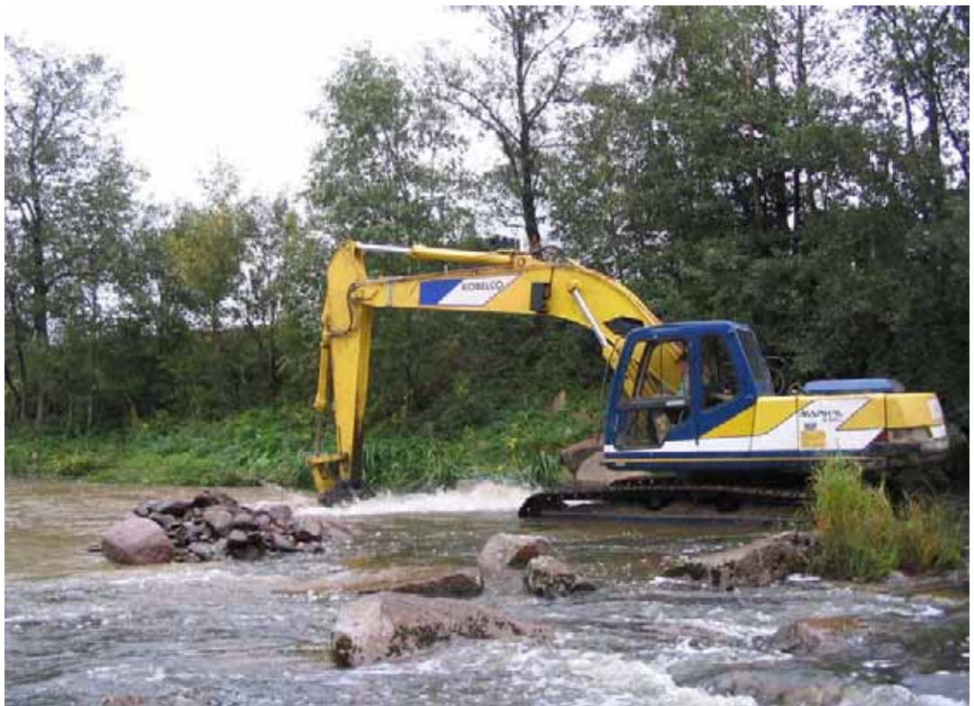
Kuva 5. Aikoinaan perattujen jokien koskialueita ennallistetaan muun muassa lohikalojen elinolosuhteiden parantamiseksi. Eurajoen kalataloudellisilla kunnostuksilla myös joen virkistyskäyttöä on lisätty. Kuvassa Suutelankosken kunnostustyö. (Kuva Henri Vaarala)
